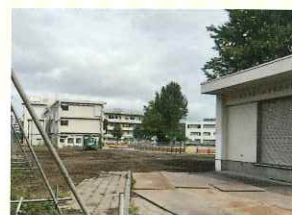
柏第三小学校 給食室工事中
